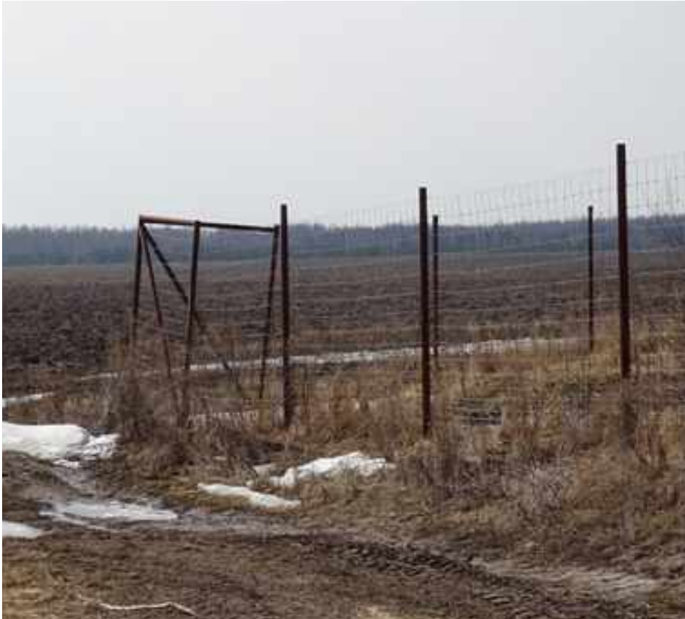
Отклонение угловых опор.
