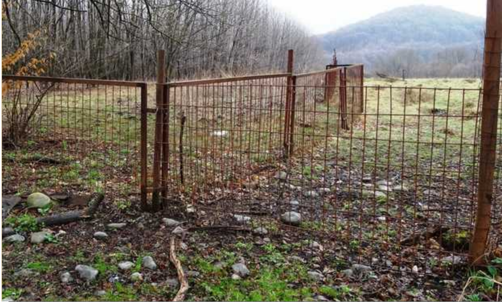
Панели из сварной сетки на металлических столбах
