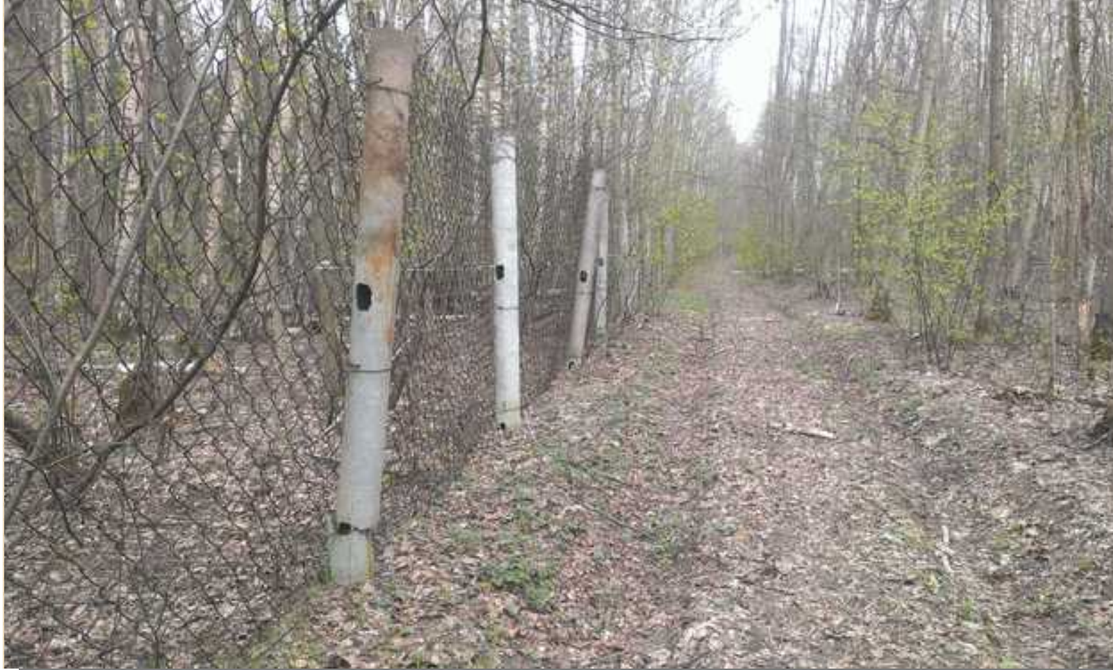
Сетка Рабица на асбестоцементных столбах
